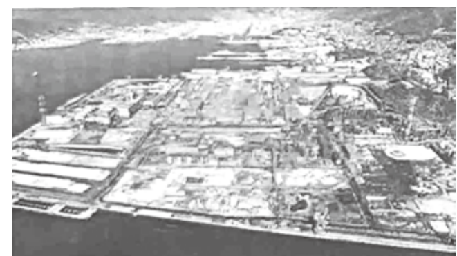
日本製鉄瀬戸内製鉄所呉地区(日鉄呉)約 130ha の広大な跡地
